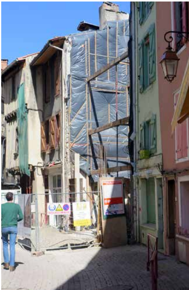
Reconstruction de trois logements et d'un commerce rue Lafaurie - Foix
