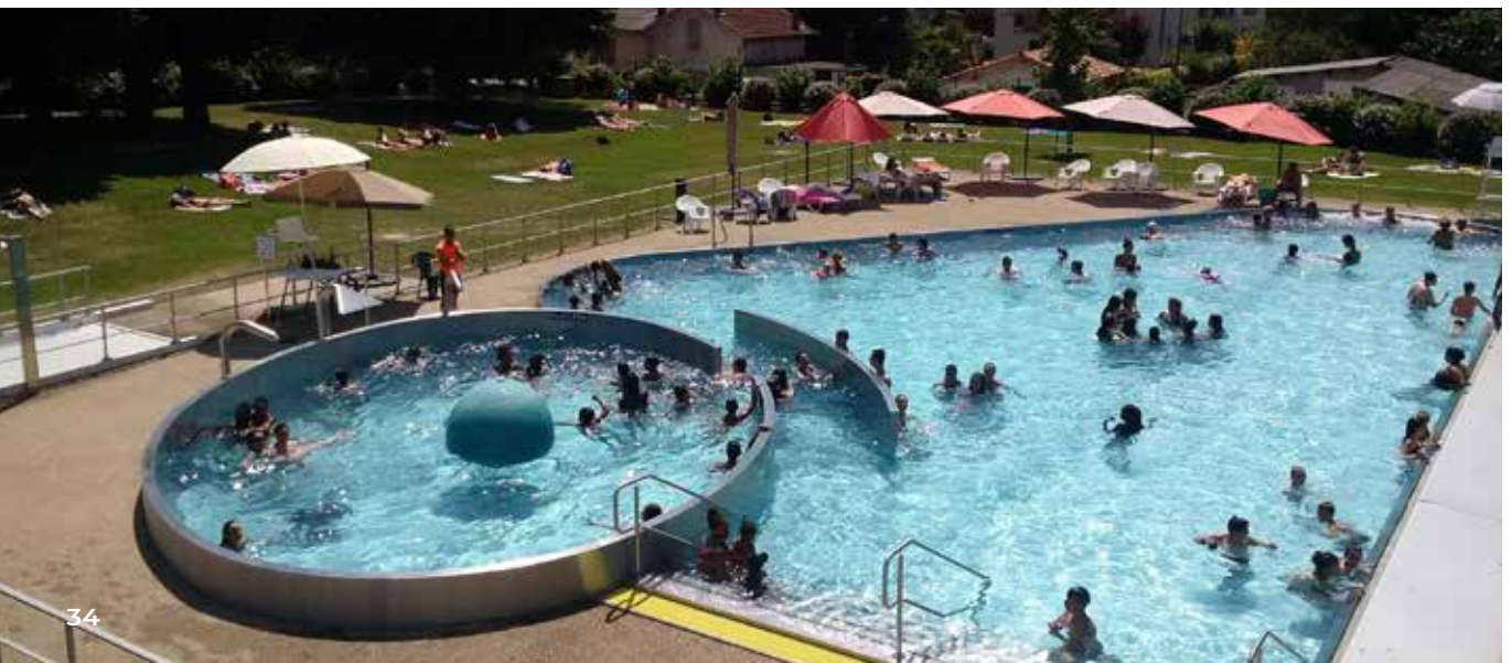
Bassin extérieur du centre aquatique - Foix
