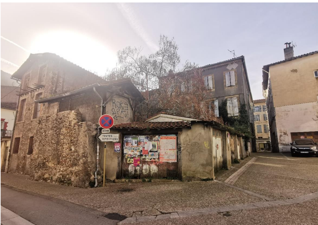
Exemple d'un jardin en partie construit et non entretenu. Source : Atelier Lavigne
