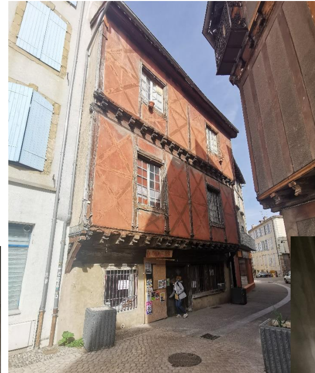
La façade à pan de bois et la distribution par un escalier et une galerie au centre du bâti.
