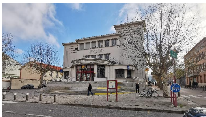
3 : La poste de Foix, et son architecture Art Déco. Photos : At. Lavigne
