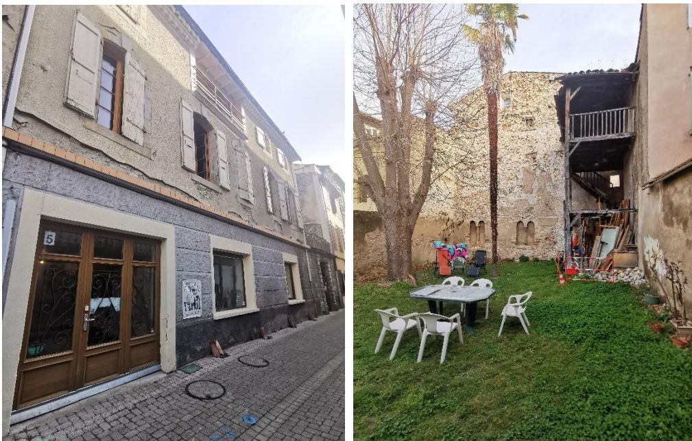
Maison avec le logement du propriétaire occupant et locaux d'artisanat en location en rdc. La façade sur rue a été très remaniée dans les années 1950. Une cour sur la rue et un jardin en terrasse à l'arrière participent à la qualité de vie de l'immeuble. Source : Atelier Lavigne
