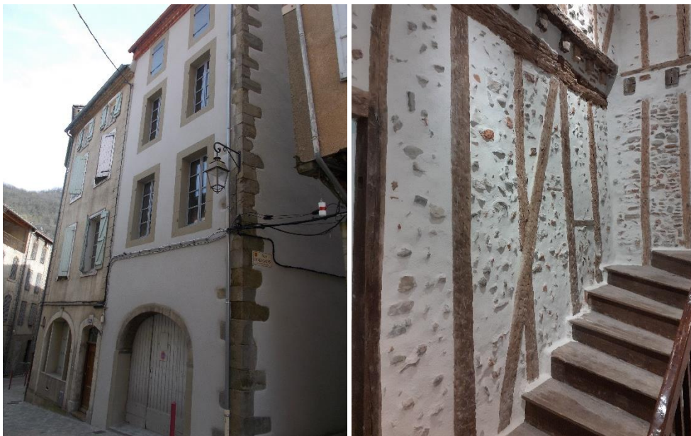
Maison avec 5 logements en location, réhabilités. La façade sur rue est cohérente. Dans les intérieurs, subsiste uniquement des structures (planchers, cloisons pans de bois) et l'escalier tournant en bois. Source : service urbanisme ville de Foix
