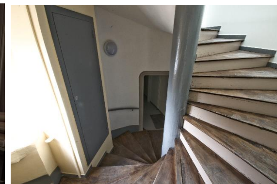
Maison des Consuls, cheminée et escalier à vis réhabilités. Source : service urbanisme ville de Foix
